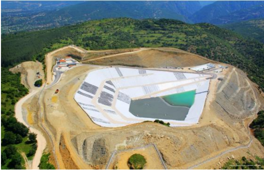
Σχήμα 1.4: Φωτογραφία του ΧΥΤΑ κατά το τελικό στάδιο κατασκευής του
