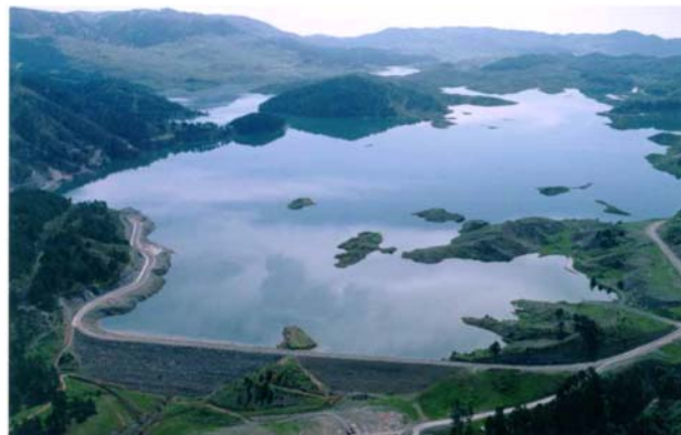
Η/Σ Πηγών Αωού (Πηγή: ΔΕΗ Α.Ε., 2009)
