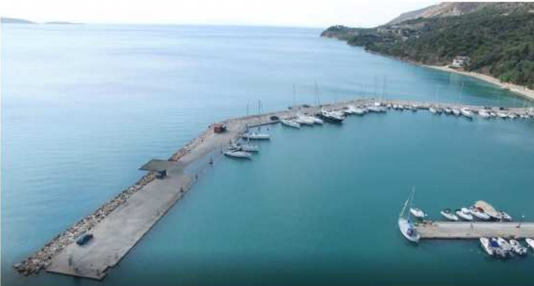
Εικόνα 4: Ο προσήνεμος μώλος του λιμένα Πλαταριάς – άποψη της εσωτερικής πλευράς/κρητίδωσης
