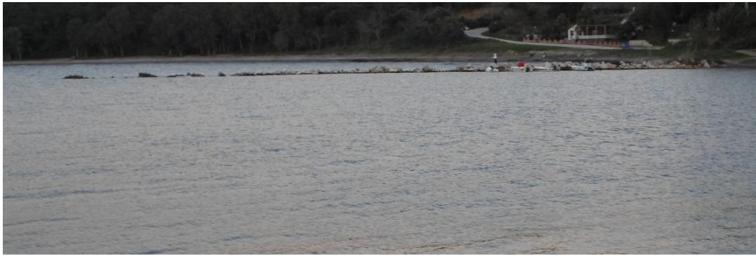
Φωτ. 5-10: Άποψη του υπήνεμου μώλου από την παραλία. Διακρίνεται η χαμηλή του στέψη καθ' όλο το μήκος της κατασκευής.
