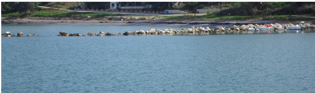
Φωτ. 5-11: Άποψη του υπήνεμου μώλου από το κρηπίδωμα του προσήνεμου. Διακρίνεται η σταδιακή βύθιση του προς την κεφαλή του.
