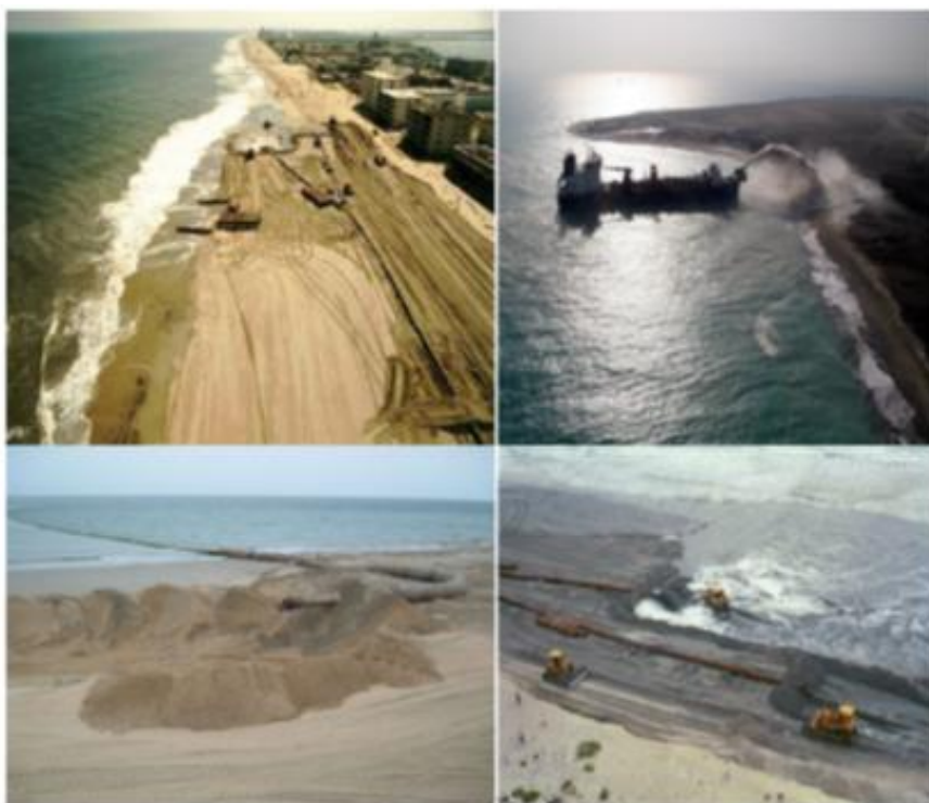
Εικόνα 8: Μέθοδοι αναπλήρωσης της ακτής ( www.blogs.oregonstate.edu ).
