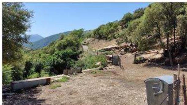
Φωτ. 7. Υπάρχον οδικό δίκτυο, εντός σταβλικής μονάδας - Τσαμαντάς
