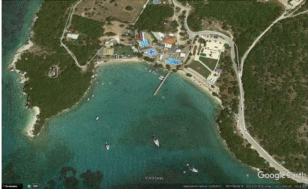
Εικόνα 3 : Υπάρχουσα κατάσταση (Απόσπασμα GoogleEarth 2017, από μελέτη)
