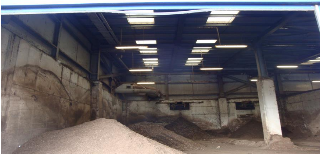
Εικόνα 10: Αποθήκευση κομπόστ με σύστημα απαγωγής αερίων
