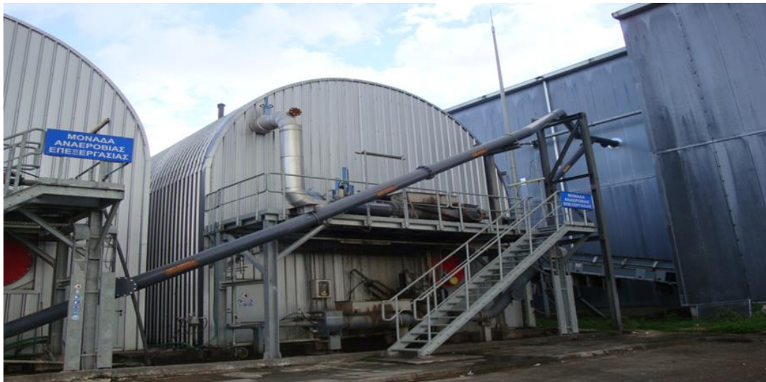
Εικόνα 7: Μονάδα αναερόβιας χώνευσης
