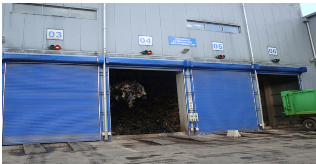
Εικόνα 6: Χώρος Παραλαβής – Αποθήκευσης Απορριμμάτων
