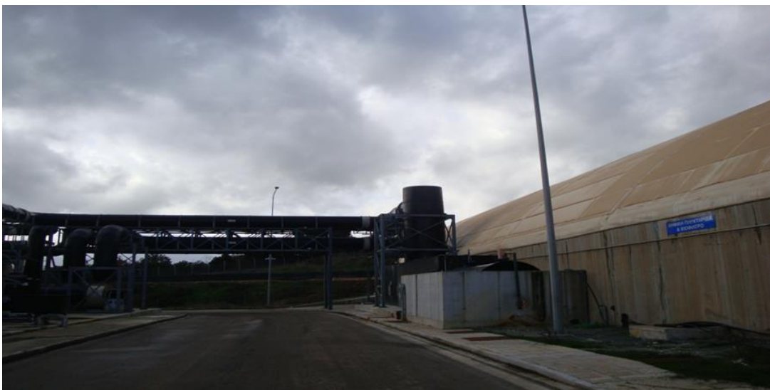
Εικόνα 12: Σύστημα απόσμησης αποτελούμενο από χημική πλυντρίδα και βιόφιλτρο
