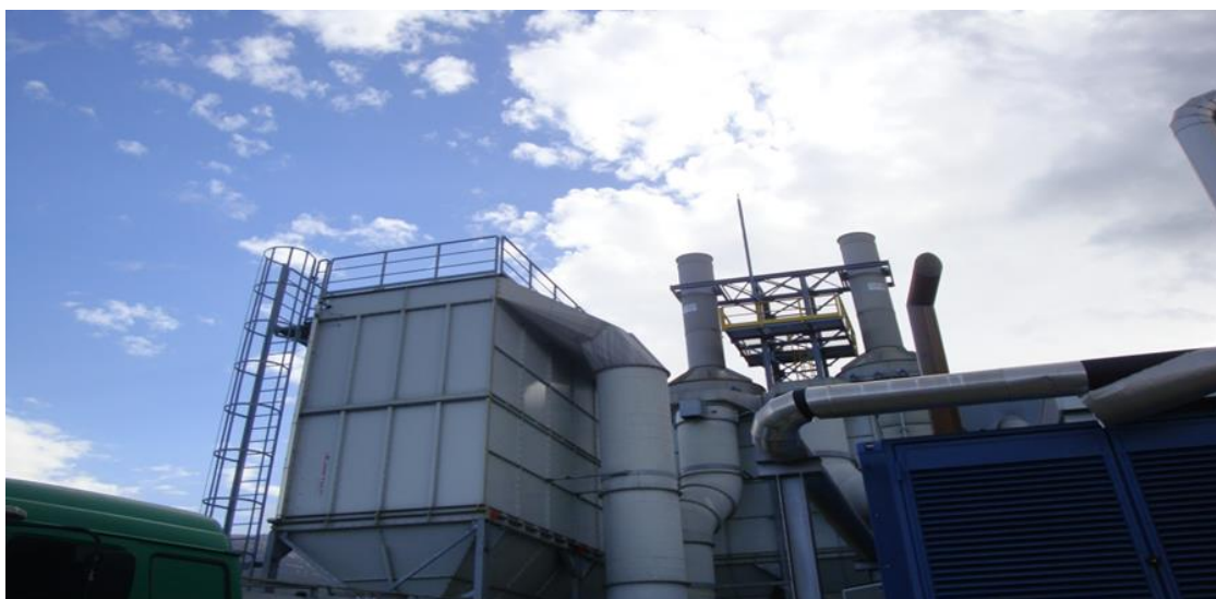
Εικόνα 9: Σύστημα απόσμησης αποτελούμενο από σακόφιλτρο και δύο πλυντρίδες
