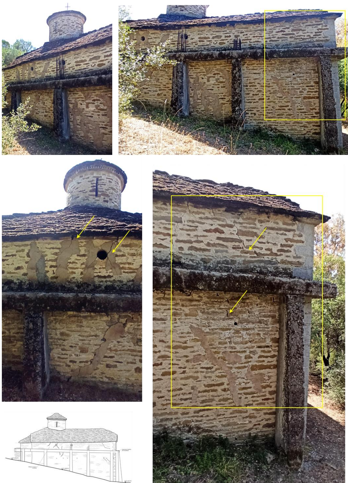
Εικ. 68. Οι επισκευασμένες ρωγμές και οι νέες ρωγμές διάνοιξης που παρατηρούνται στη βόρεια όψη του μνημείου. Ιδιαίτερα στην περιοχή της στρόγγυλης φορτοθυρίδας κοντά στον τρούλο έχουν διευρυνθεί και οι αρμοί επαφής των γρηπιδων του περιμετρικού γείσου.
