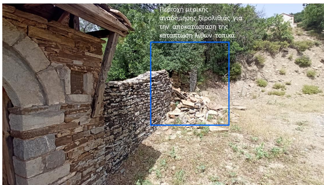
Εικ. Β19. Η περιοχή αναδόμησης της ξερολιθιάς νότια, λόγω καταρευσης, για αποκατάσταση αρχικής μορφής ως ήταν.
