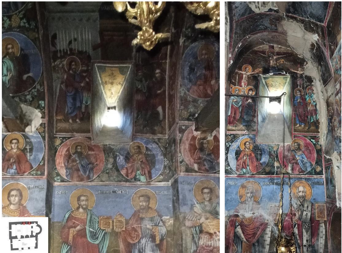
Εικ. 37. Η θέση των 4 διαμπερών, στρόγγυλων φωτοθυρίδων που διατάσσονται συμμετρικά δύο σε κάθε πλευρά, βόρεια και νότια του κυρίως κεντρικού ναού, και η εσωτερική διεύρυνση που υπάρχει για τη διάχυση του φωτός.
