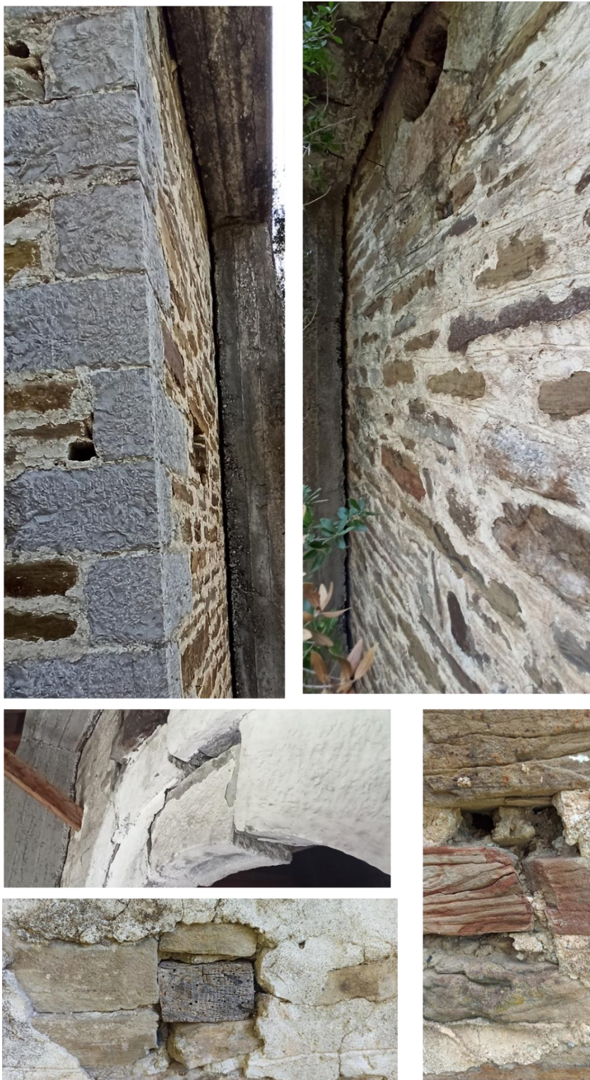
Εικ. 62. Ενδεικτικές εικόνες της λιθοδομής με χρήση διαφορετικών ειδών λίθου. Η γκρίζα όμως πέτρα είναι αυτή που πλεονάζει.
