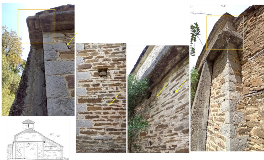
Εικ. 69. Οι ρωγμές στη λιθοδομή και αποδιοργανωμένοι κόμβοι περίδεσης της συνδετήριας δοκού από Ο/Σ στη δυτική πλευρά του μνημείου.
