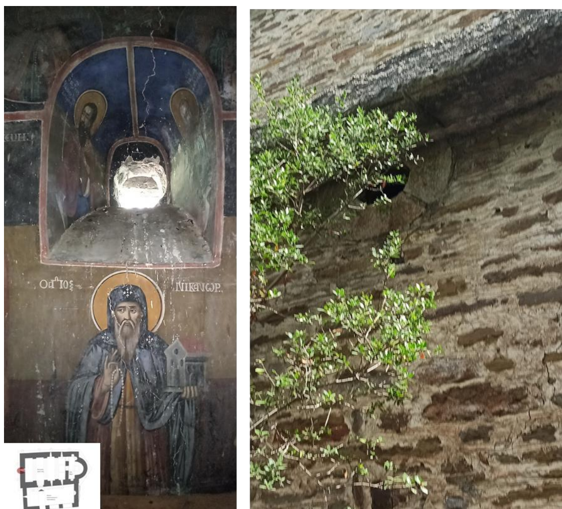
Εικ. 35. Απόψεις εξωτερικά και εσωτερικά της φωτοθυρίδας του δυτικού τοίχου με τις αντίστοιχες διαμορφώσεις στην τοιχοδομή.
