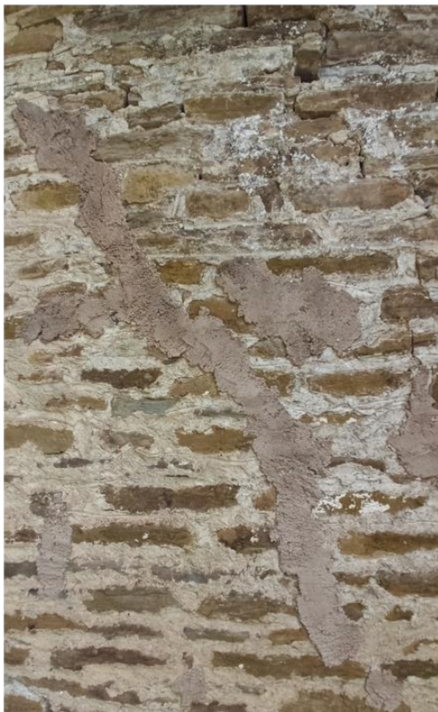
Εικ. 60. Ενδεικτικές εικόνες διαφόρων επισκευαστικών κονιαμάτων καθώς και αρμολογημάτων και επιχρισμάτων εξωτερικά και εσωτερικά του ναού. Είναι εμφανείς οι ποικίλες επεμβάσεις που έχει δεχθεί το μνημείο σε βάθος χρόνου.
