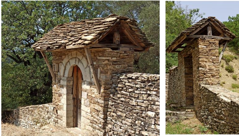
Εικ. 50. Άποψη της λιθόκτιστης εισόδου του αύλειου χώρου της Μονής Καβασίων που είναι στεγασμένη με ξύλινο στέγαστρο και που καλύπτεται και αυτό με σχιστόπλακες.
