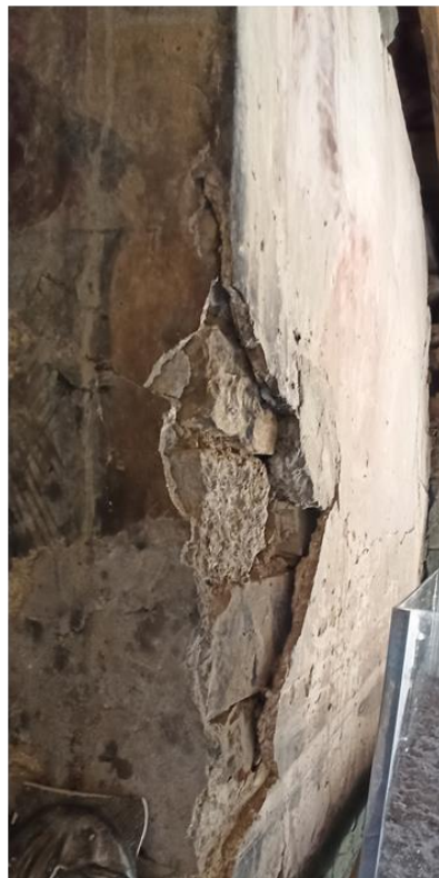
Εικ. 60. Ενδεικτικές εικόνες διαφόρων επισκευαστικών κονιαμάτων καθώς και αρμολογημάτων και επιχρισμάτων εξωτερικά και εσωτερικά του ναού. Είναι εμφανείς οι ποικίλες επεμβάσεις που έχει δεχθεί το μνημείο σε βάθος χρόνου.
