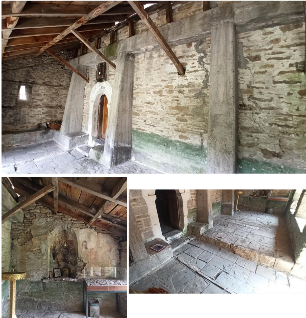
Εικ. 45. Απόψεις των περιμετρικών τοιχοδομών του χαγιατιού μαζί το ξύλινο σκελετό της στέγης του και της ειδικής διαμόρφωσης λίθινου διαδρόμου προς την είσοδο στο εσωτερικό του κυρίως ναού.
