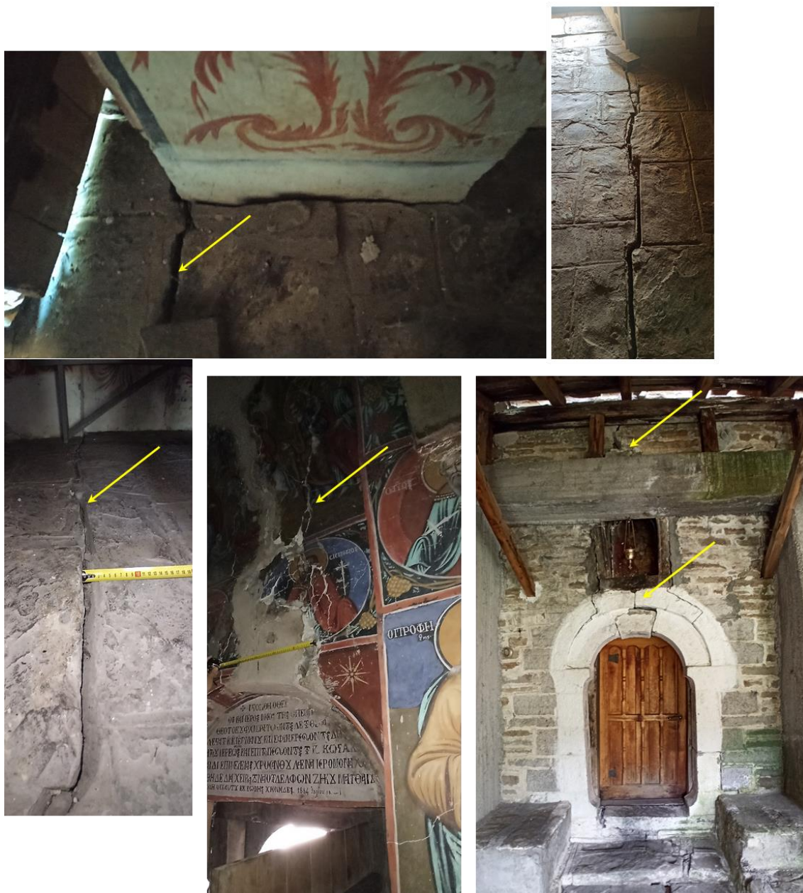
Εικ. 78. Η θέση της μεγάλης ρωγμής που παρατηρείται στο δάπεδο του ναού και ξεκινά από το βόρειο στο νότιο τοίχο και η παραμόρφωση που έχει προκαλέσει με τις επιμέρους βλάβες στο άνω μέρος της εισόδου του ναού. Η παθολογία είναι έντονη τόσο εσωτερικά όσο και εξωτερικά της εισόδου.
