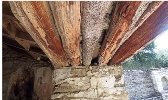
Τα ξύλα στο ανώφλι των ανοιγμάτων του χαγιατιού. Δημιουργούν ισχυρό οριζόντιο διάζωμα.
