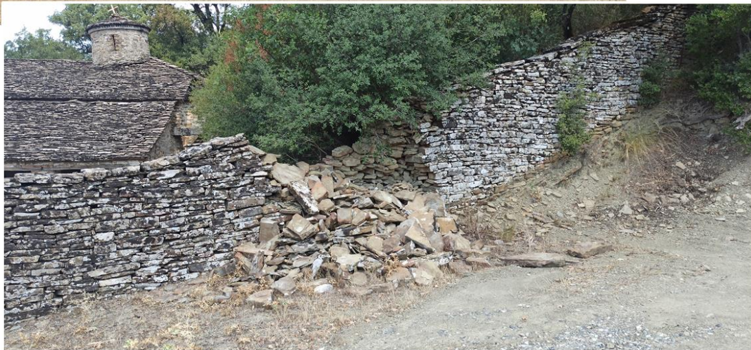
Εικ. 74. Η περιοχή κατάρρευσης και αποδιοργάνωσης της ξερολιθιάς του νότιου περιβόλου από την εξωτερική πλευρά.
