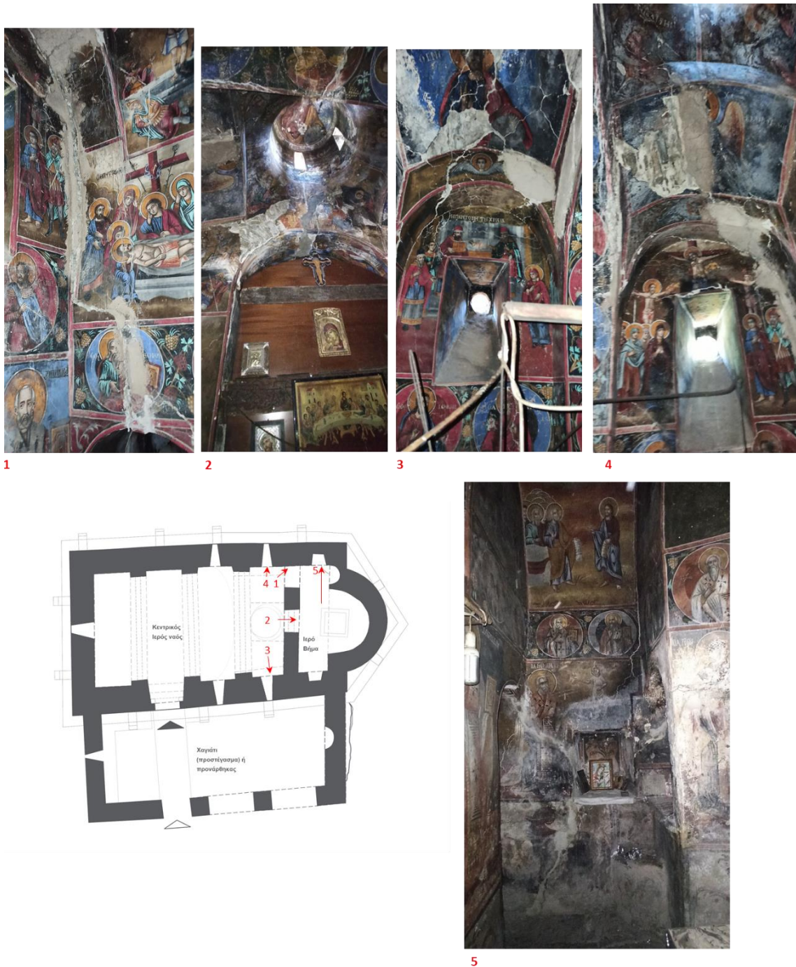
Εικ. 77. Επιμέρους περιοχές γύρω από την περιοχή του τρούλου και του Ιερού όπου φαίνεται η εκτεταμένη κατάσταση αποδιοργάνωσης και παθολογίας. Ειδικά στο χώρο του Ιερού παρατηρείται και η δράση της υγρασίας.
