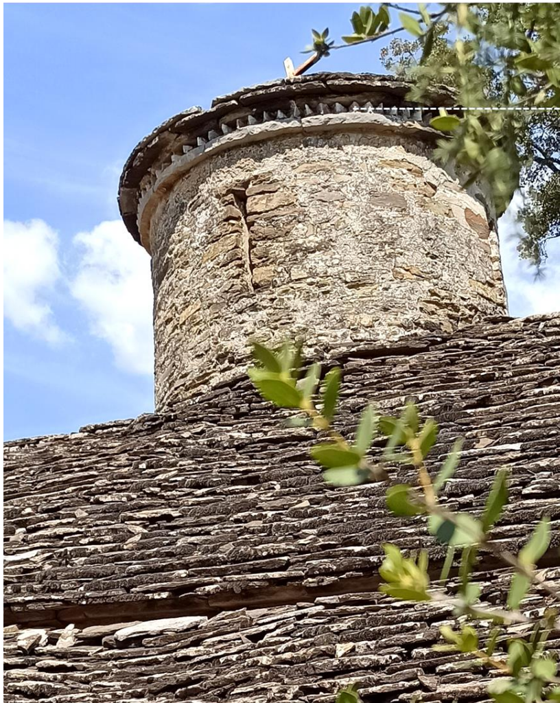
Εικ. 27. Επιμέρους μορφολογικές λεπτομέρειες στην απόληξη του γείσου των στεγών από την ανατολική πλευρά καθώς και της εξωτερικής όψης των φωτιστικών θυρίδων του τρούλου.
