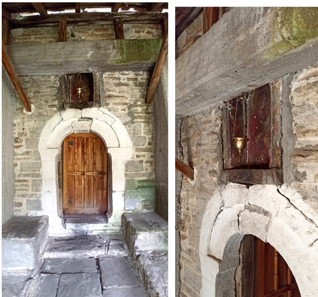
Εικ. 38. Απόψεις εξωτερικά της εισόδου με το τοξωτό υπέρθυρο και το τυφλό αψίδωμα. της Μονής Καβασίλων. Η παρουσία της περιμετρικής συνδετήριας δοκού από Ο/Σ φαίνεται πώς υποβαθμίζει αισθητικά την εικόνα της.
