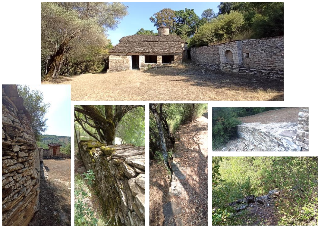
Εικ. 51. Απόψεις της ξερολιθιάς περιτοίχησης της Μονής, όπου φαίνεται ότι η μορφή της κάθε φορά προσαρμόζεται στο φυσικό ανάγλυφο του περιβάλλοντος χώρου.
