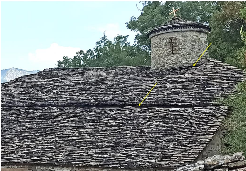
Εικ. 72. Η κλίση του τρούλου και περιοχές παθολογίας στην επιστέγαση της στέγης.
