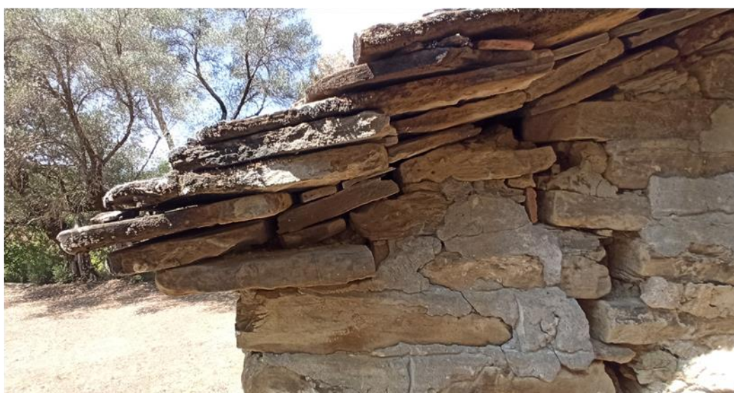
Εικ. 63. Ενδεικτικές εικόνες της επιστέγασης με μαυρόπλακες και ο τρόπος διάταξης τους από ανατολικά.
