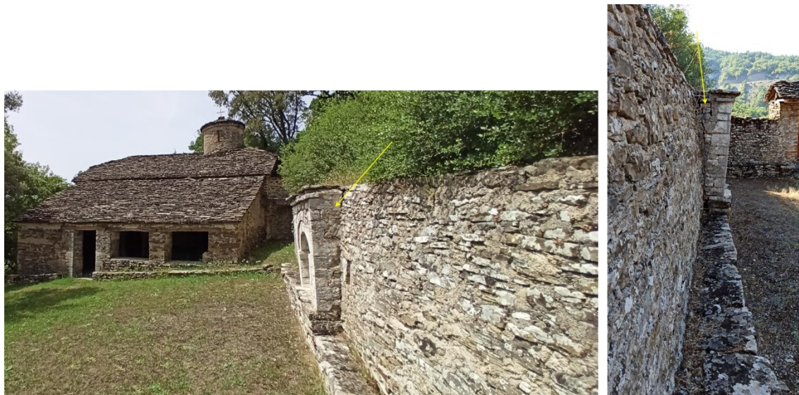
Εικ. 73. Απόψεις του ανατολικού λιθόκτιστου περιβόλου που έχει υποστεί συμπληρώσεις με λίθους και επισκευαστικά κονιάματα σε περιοχές παραμορφώσεων , όπως πίσω από λιθόκτιστη κρήνη.
