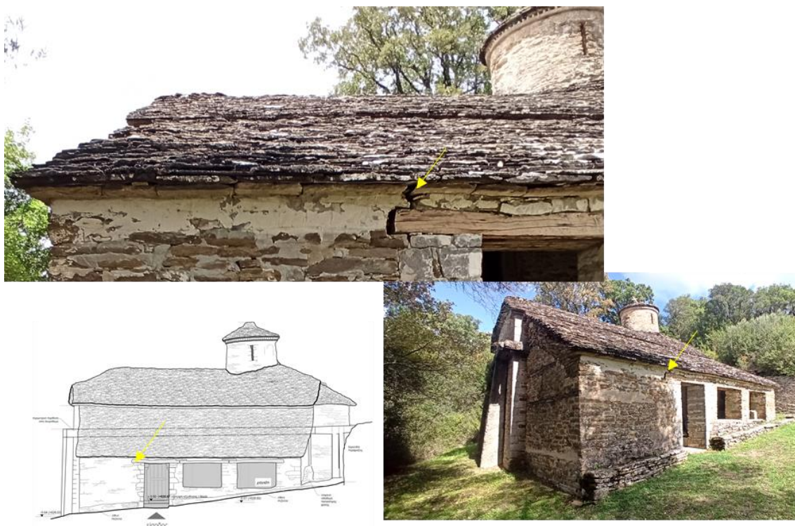
Εικ. 70. Οι ρωγμές αποκόλλησης του ξύλινου διαζώματος των ανοιγμάτων από την λιθοδομή στη νότια πλευρά του χαγιατιού.
