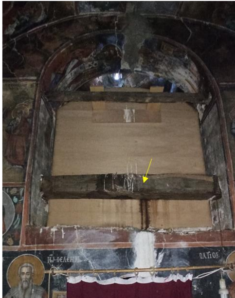
Η ξύλινη δοκός- ελκυστήρας εντός στο λίθινο τέμπλο του Ιερού.
