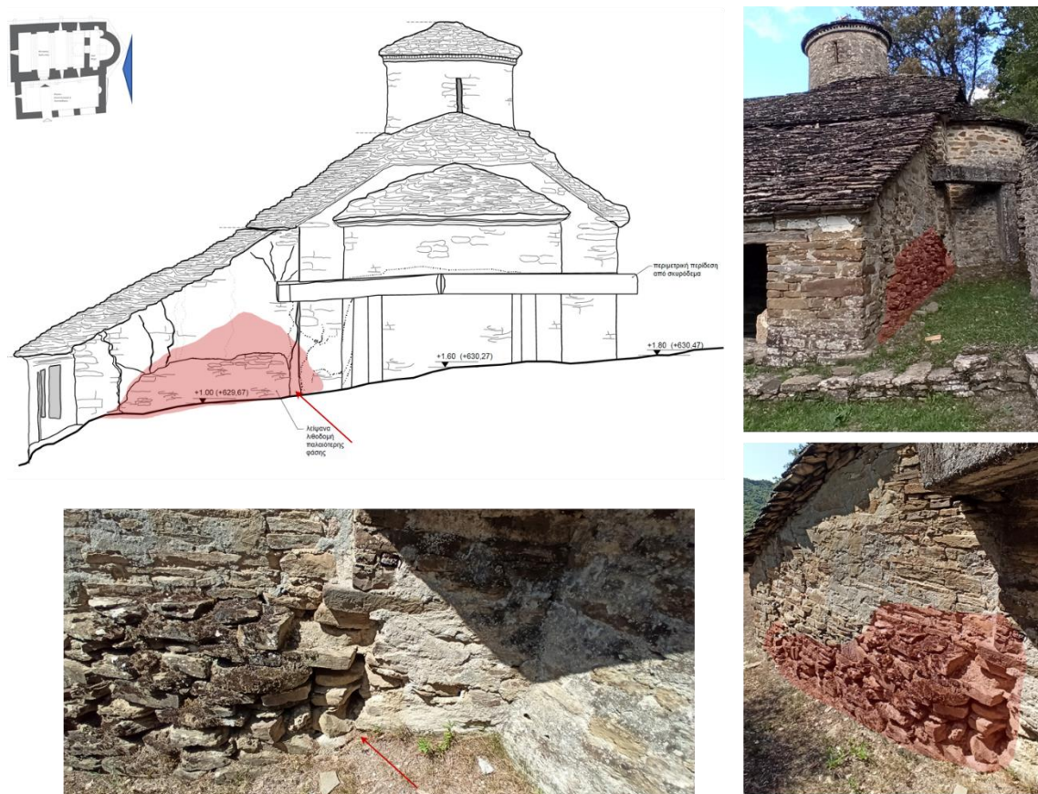
Εικ. 65. Η θέση των λειψάνων παλαιότερης οικοδομικής φάσης (1 η ΟΙΚΟΔΟΜΙΚΗ ΦΑΣΗ) στην ανατολική όψη του μνημείου και ο τρόπος σύνδεσής τους με την υπόλοιπη λιθοδομή.
