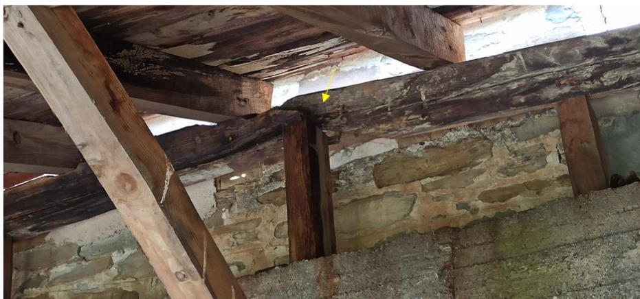
Η μεγάλη ξύλινη δοκός στήριξης της στέγης του χαγιατιού.
