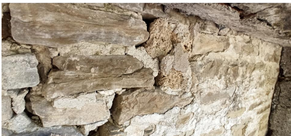
Εικ. 61. Ομοίως με προηγούμενως, ενδεικτικές εικόνες διαφόρων επισκευαστικών κονιαμάτων καθώς και αρμολογημάτων. Διακρίνεται μεγάλη ποικιλία κονιαμάτων και παραμένει ασαφές ποιο είναι το αρχικό παλαιό κονίαμα δόμησης. Το πιθανότερο είναι να πρόκειται για πηλοκονίαμα που έχει σταδιακά εξασθενήσει και αποσαθρωθεί.
