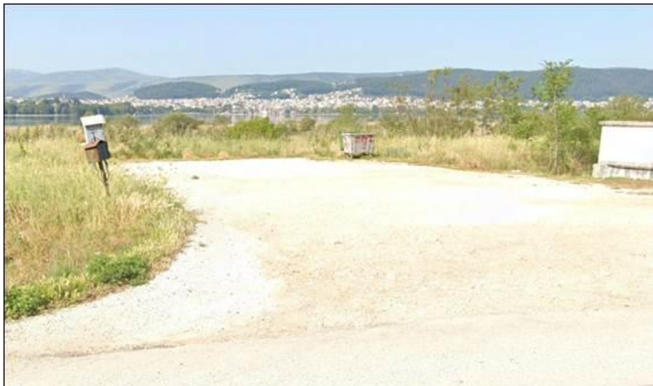
Εικόνα: Σημείο έναρξης κατασκευής του προτεινόμενου αναχώματος
