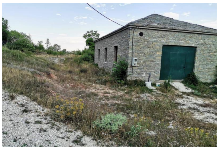
Εικόνα 3.: Κτίριο εγκατάστασης επεξεργασίας λυμάτων Τ.Κ. Παπίγκου.
